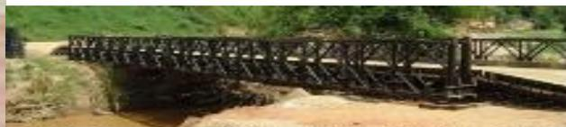
Foto 10: Ponte Beliz, tipo 'Duplo-Singlo' Foto do manual [T.E. 57] – 'Ponte do Protótipo Toxicology M2'
