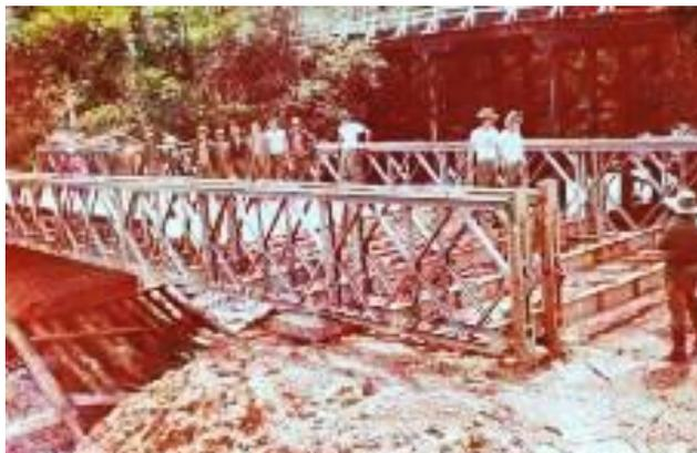
Foto 13: Ponte Bailey "Copa Simões" sendo construída durante a época de seca. Às costas, a Ponte de madeira original, sobre o igarapé dos Leões.
