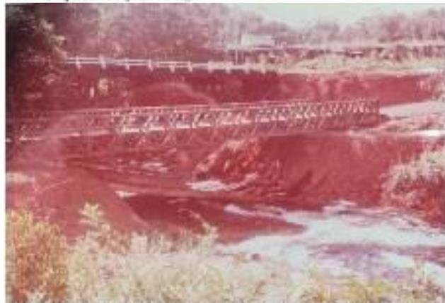
Foto 15: Ponte Bailey "Copa Simões" no fundo, e Ponte de madeira original, sobre o igarapé dos Leões.
