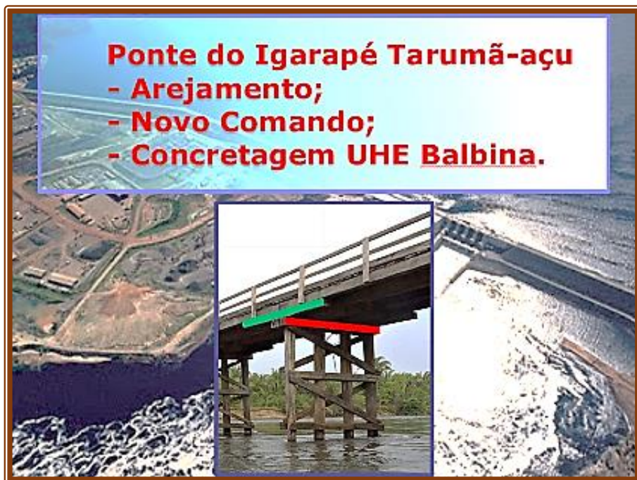
Imagem 03 – Ponte do Tarumã-açu, BR-174
