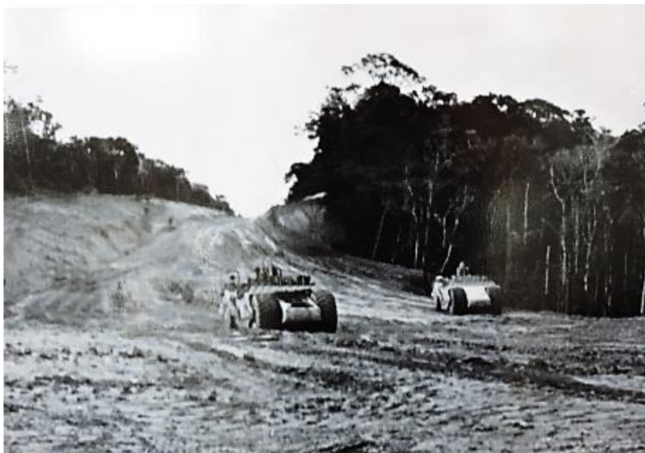
Imagem 17 – Construção BR-174 (ST Ávila)
